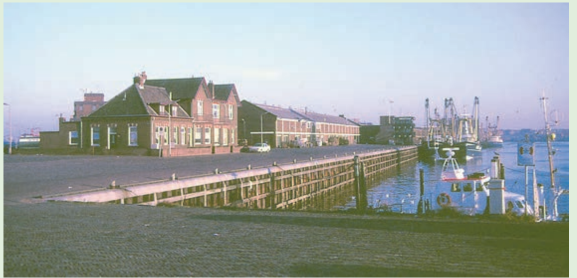
Op deze dia van ca. 1990 zien we de naoorlogse Tegeltesmarkt, met van links naar rechts de dienstwoningen, hal A en het voormalige havenkantoor. Rechts zien we de reddingboot Johanna Louisa liggen aan de steiger bij de kop van de haven. Foto: Erik Baalbergen
