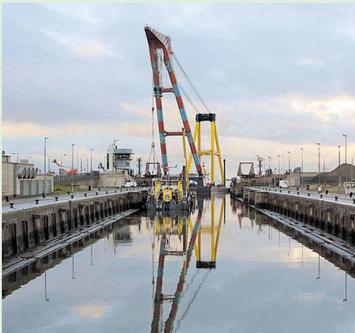
De HEBO-Lift 9 neemt de zuidelijke brug boven het buitenhoofd van de Middensluis in de takels. Foto: Erik Baalbergen
