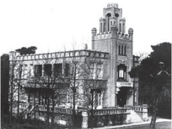
Najade met klokkenstoel na de verbouwing in 1931. Na 1948 was hier het rusthuis en de kraamkliniek Maranatha gevestigd. Nog later was het dependance van het Provinciaal Ziekenhuis.
