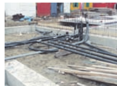
De leidingen in de kruipruimte
