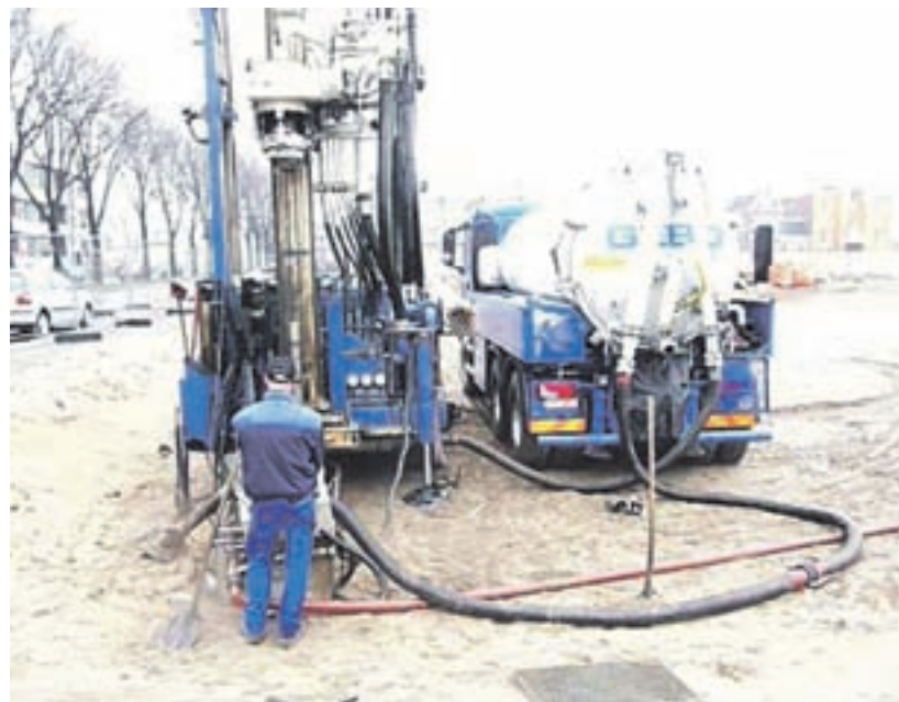
De pijpen voor de warmtekoude opslag
