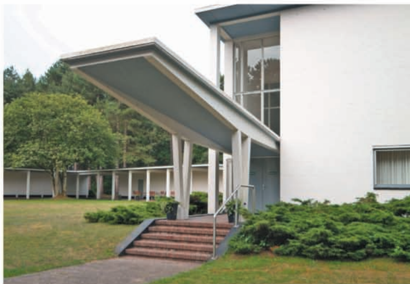
FOTO: Dudok-aula, Begraafplaats Duinhof.
