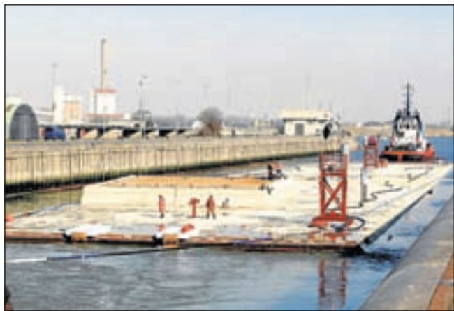
IJmuiden - Zondagmiddag arriveerde het eerste tunnelelement voor de Tweede Coentunnel in IJmuiden. De passage van de sluisen trok veel bekijks. De elementen zijn elk 178 meter lang, 30 meter breed en 85, meter hoog. Ze zijn gemaakt in het bouwdok Barendrecht. Er komen nog tunneldelen voorbij op 30 maart en 6 april. (foto: Rein-der Weidijk)
