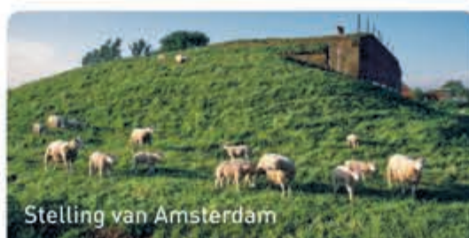
Tankversperring bij Fort Everdingen
